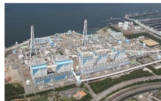
アンモニア専焼を目指す JERA碧南火力発電所
