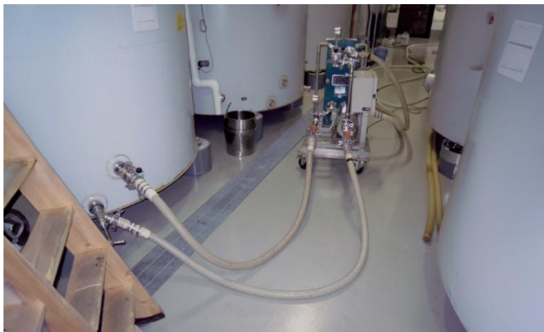
出典：新洋技研工業 (タンクとポンプの接続)
